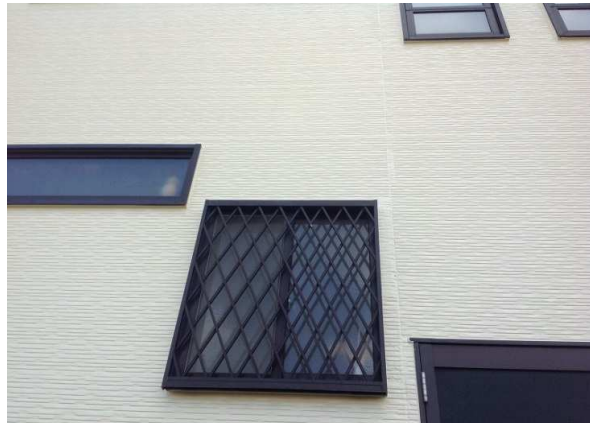
⑥施工完了
