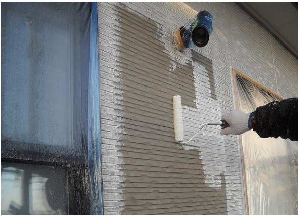
③外壁下塗り
