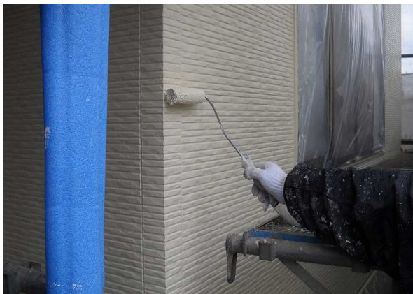
⑤外壁上塗2回目
