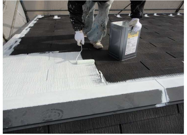
②屋根下塗り
