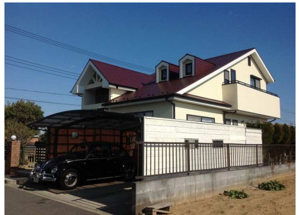
⑥工事完了
