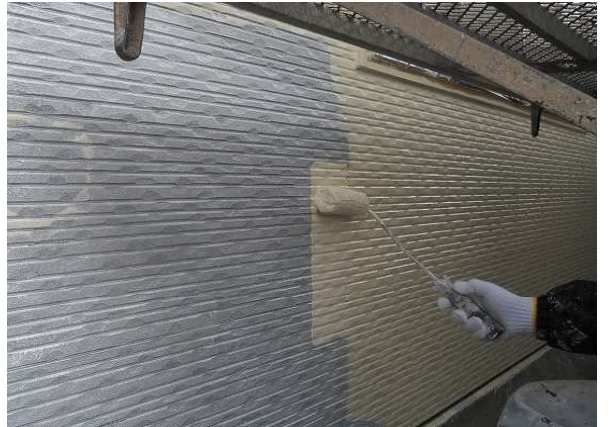
④外壁上塗1回目
